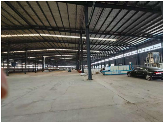
车间现状照片（东往西拍摄）
