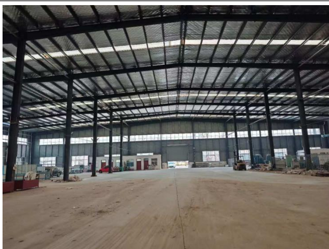
车间现状照片（西往东拍摄）
